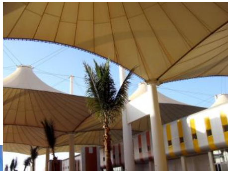
سازه چادری فرودگاه حجاج جده با تهویه مطبوع
